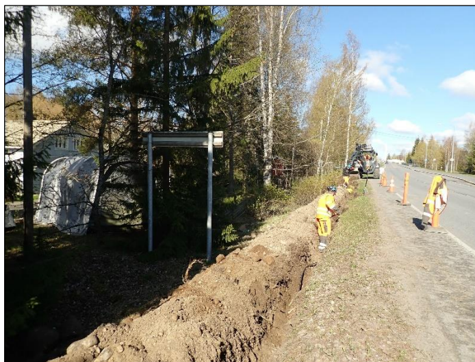
Näkymä valvomatta kaivetulta osuudelta. Kaapelia kaivetaan tien penkkaan, joka on kokonaan paikalle tuotua moreenia. Kuvattu länteen.
