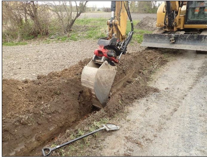
Kaapelia kaivetaan tien penkkaan, joka on kokonaan paikalle tuotua moreenia. Kuvattu länteen.
